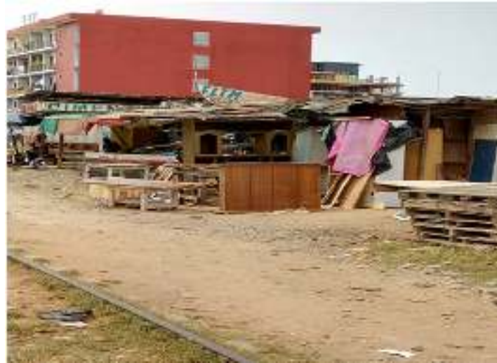
Photo 2 : Activités de menuiserie sous hangar, cliché : WADJA, 2020
