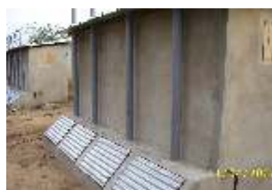
Photo 4: Latrine EcoSan, vue arrière
