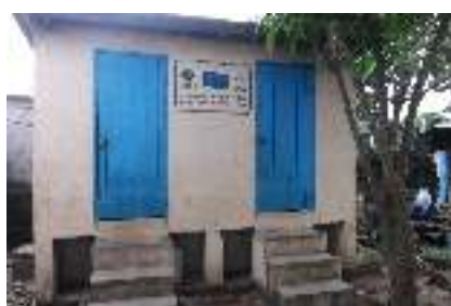
Photo 3: Latrine EcoSan, vue de face
